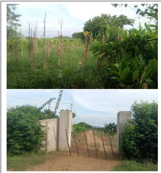
Imágenes N° 2 – del estado actual del punto de taponamiento
